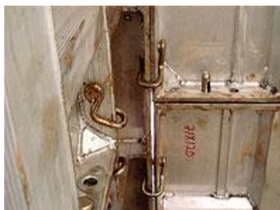
Foto 11 - Colocação dos grampos de fixação entre fôrmas de parede e painéis
