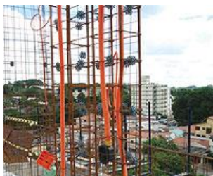
Foto 14 - Espaçadores plásticos garantem o cobrimento da placa e o posicionamento da armadura
