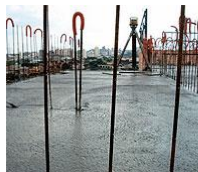
Foto 5 - Nivelamento de laje com auxílio de nível laser
