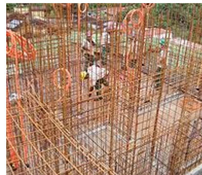
Foto 6 - Montagem das armaduras de paredes e eletrodutos
