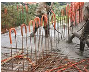
Foto 18 - Concretagem de paredes e lajes em fôrma de alumínio com auxílio de bomba-lança
