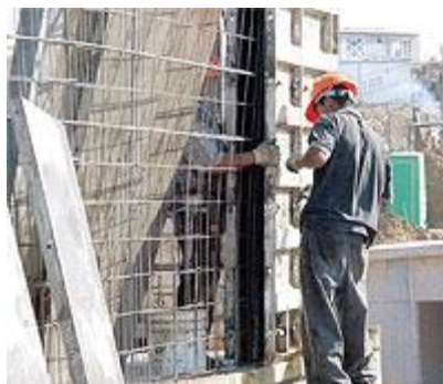
Foto 10 - Montagem pareada (painéis internos e externos simultaneamente)
