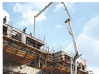
Foto 19 - Adensamento de concreto com vibrador de mangote
