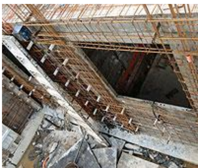
Foto 9 - Montagem dos painéis externos
