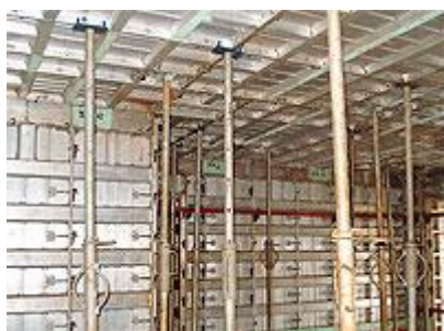
Foto 12 - Escoramento dos painéis de laje
