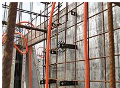
Foto 11 - Colocação dos grampos de fixação entre fôrmas de parede e painéis
