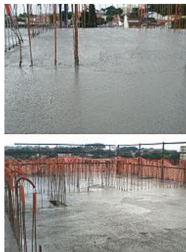
Concreto utilizado em construções de pavimentos-tipo de edifícios residenciais
