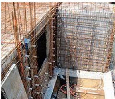
Foto 8 - Montagem dos painéis internos de fôrmas de alumínio
